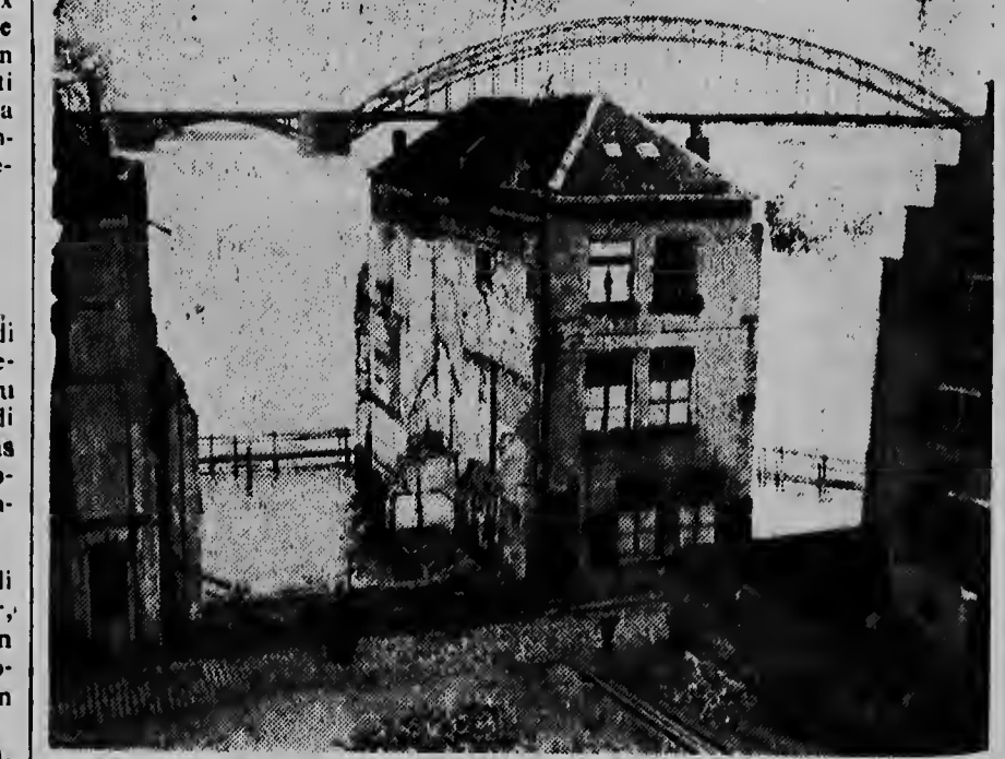
Het water van de rivier de Waal is sterk gestegen, waardoor de benedenstad van Nijmegen onder water is gelopen. Een van de huizen aan de Waalkade, die geheel door water wordt omspoeld.
